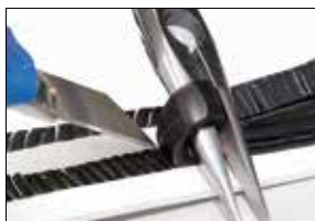
Afb. 2: Verwijder de uitgeharden rups met een tangetje
